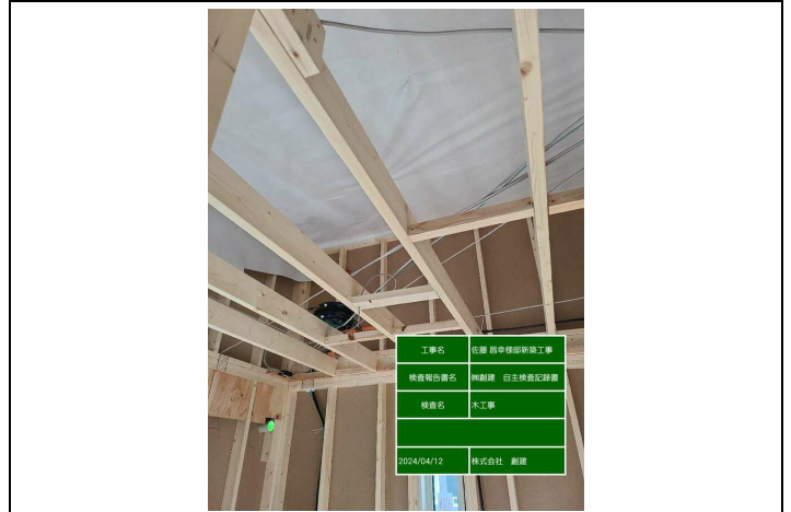
【造作】小屋裏遮熱材の施工
