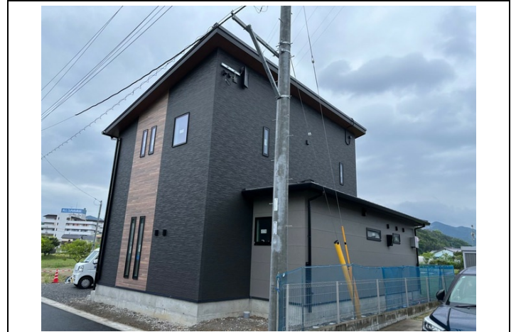
☑解体完了② (全体)
