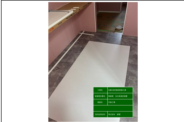
【クッションフロア】完了後の清掃・養生
