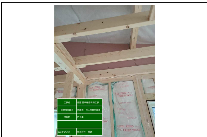
【造作】小屋裏妻面PB12.5張上げ
