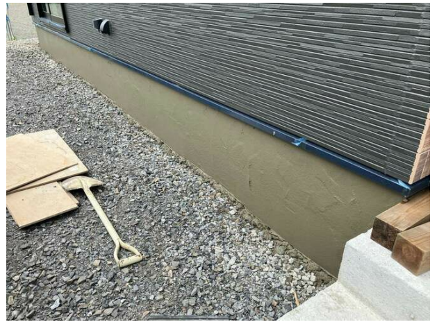
☑基礎巾木 施工中②
