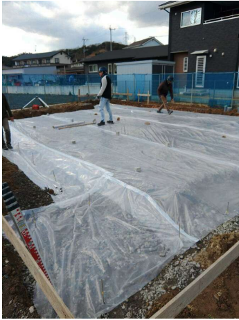
【防湿フィルム】防湿フィルムが施工されている（重ね巾150mm以上）
