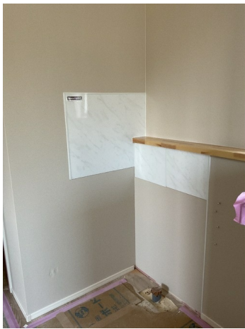
☑カップボード 施工中③
