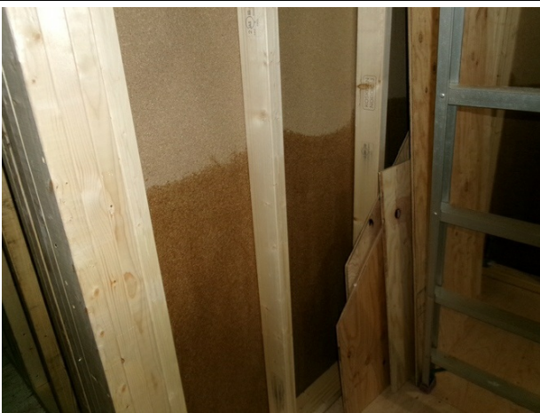
【木部処理】柱・間柱・筋交い・スタッドなど軸組・枠組構造材基礎天端より1.0m以上の吹き付け
