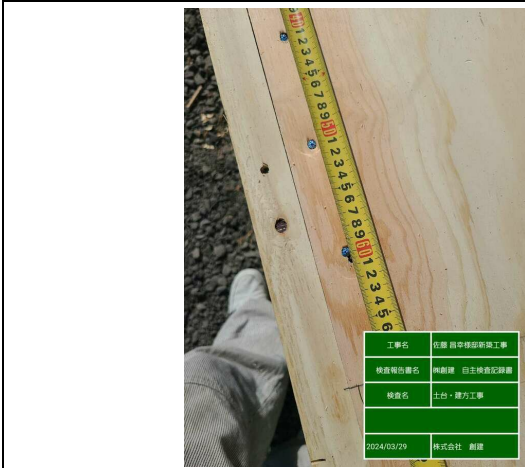
【土台敷き】床合板釘CN75（外周@150・中央@200）※耐力壁区画線（外周@100）
