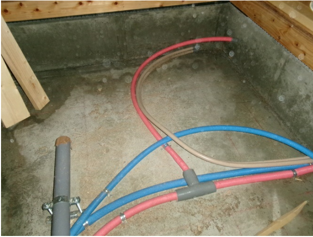
【床下処理】床下散布状況
