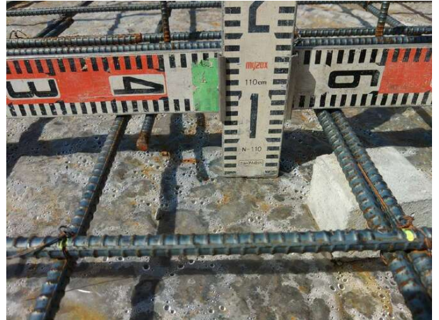
【配筋】スラブ筋下かぶり厚さ（60mm）
