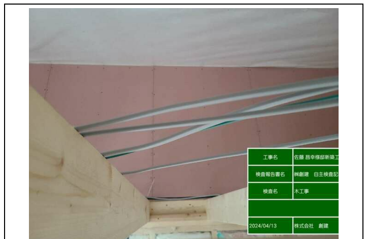
【造作】小屋裏妻面PB12.5張上げ
