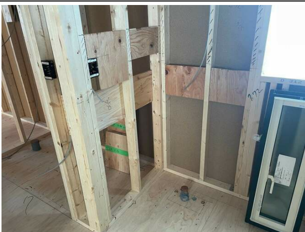
【屋内】器具取付用の下地は入れ確認
