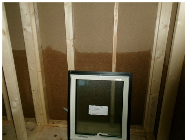
【木部処理】柱・間柱・筋交い・スタッドなど軸組・枠組構造材基礎天端より1.0m以上の吹き付け
