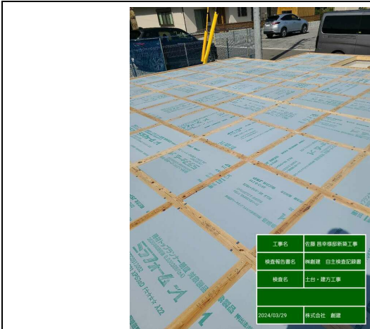
【土台敷き】床断熱材の敷込み隙間、止金具の取付に不備がないか全景確認
