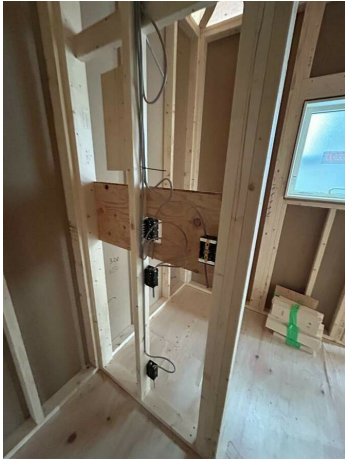
【配線】スイッチ・コンセントBOX位置・固定の確認
