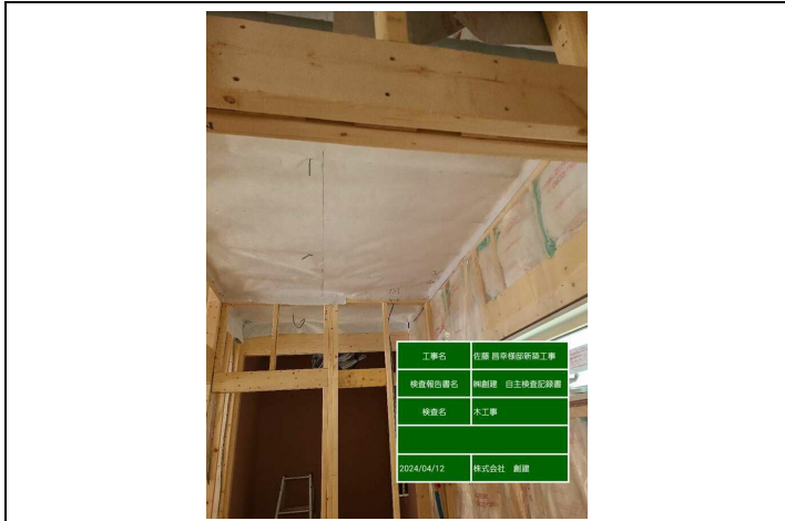
【造作】小屋裏遮熱材の施工
