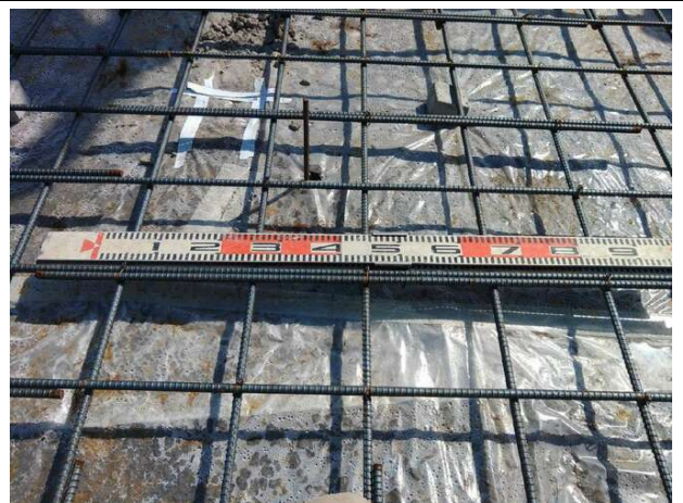
【配筋】スラブ配筋ピッチは図面通りか
