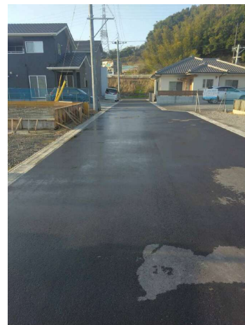
【コンクリート 打設その他】片付・残材の撤去・清掃は完了したか
