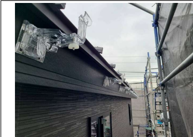
【樋工事】軒樋の受金物間隔600mm程度
