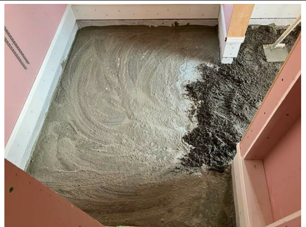
☑タイル 施工中①
