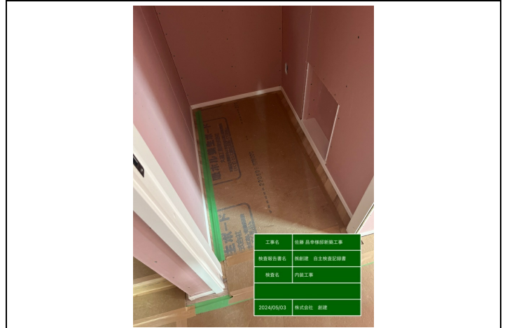
【クッションフロア】完了後の清掃・養生
