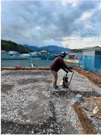
【根伐地業】 砂利地業転圧は十分行ったか
