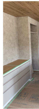
☑カップボード 設置完了（全体）
