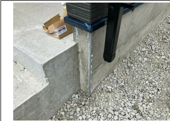
☑基礎巾木 施工中①
