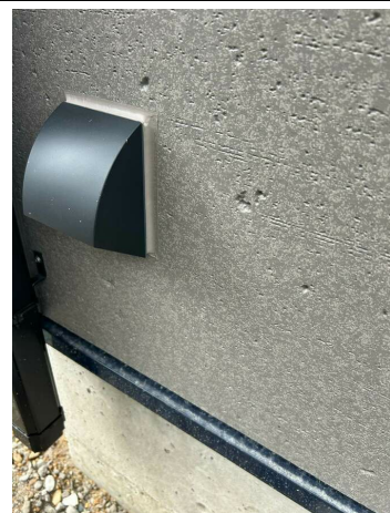
外部 器具・フード周りシーリング処理
