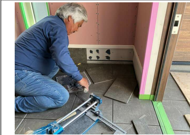
☒タイル 施工中②
