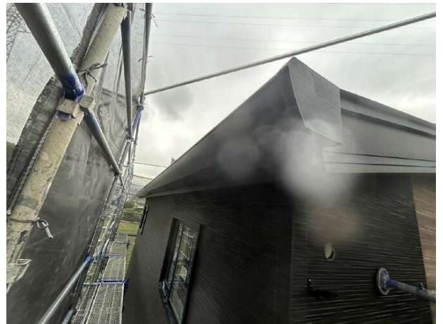
【樋工事】軒樋の緊結確認
