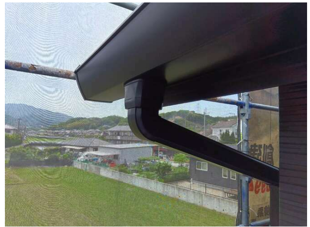
【樋工事】角桷取付の緊結確認
