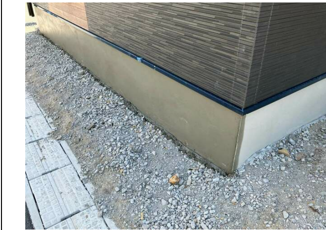
☑基礎巾木 完成
