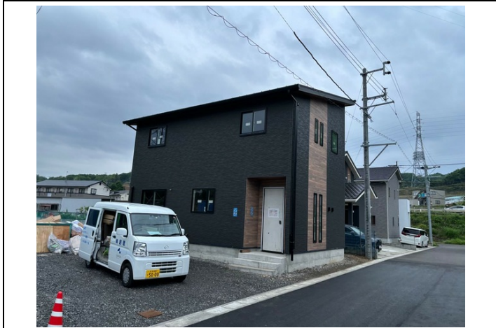
☑解体完了① (全体)
