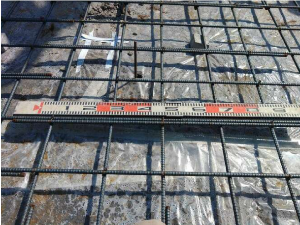
【配筋】スラブ筋継手長さ40 d 以上
