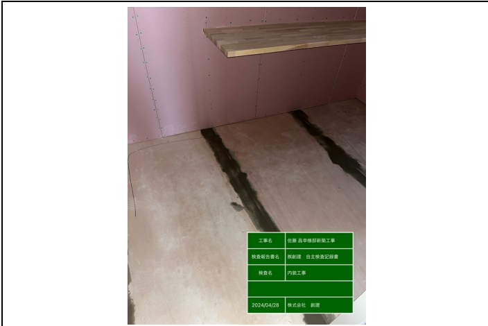
【クッションフロア】下地処理後の清掃・凹凸の確認
