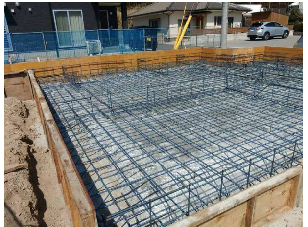
【配筋】配筋全景確認
