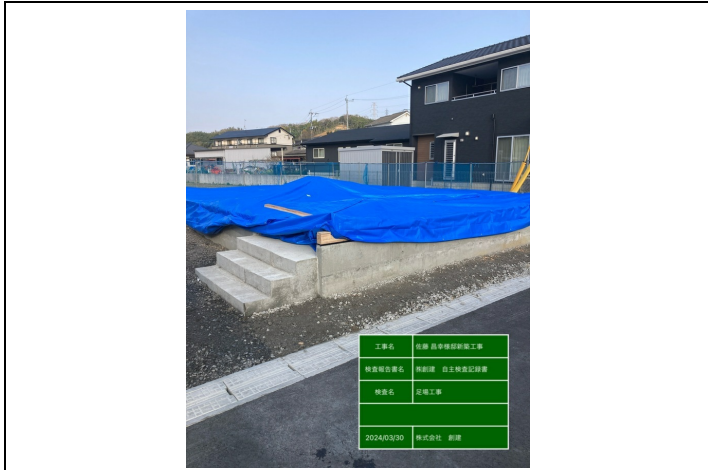
☑組立施工前 (全体)
