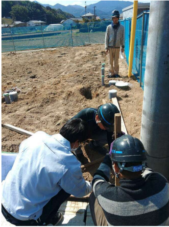
【遣方】遣方天端の確認（BM+□mm=設計GL）
