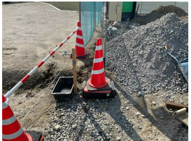
【屋外】樹・メーターボックスの養生確認
