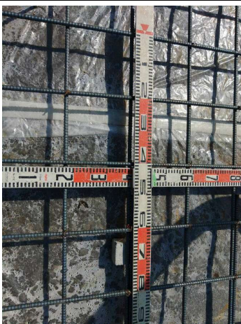
【配筋】スラブ配筋ピッチは図面通りか
