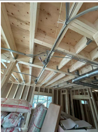
【配線】電線及び電線管の支持は良いか
