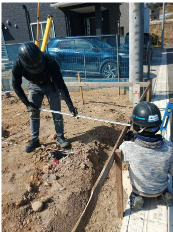
【遣方】遣方天端の確認（BM+□mm=設計GL）
