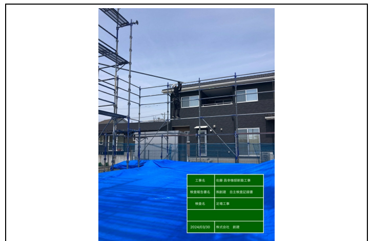
☑組立施工中②
