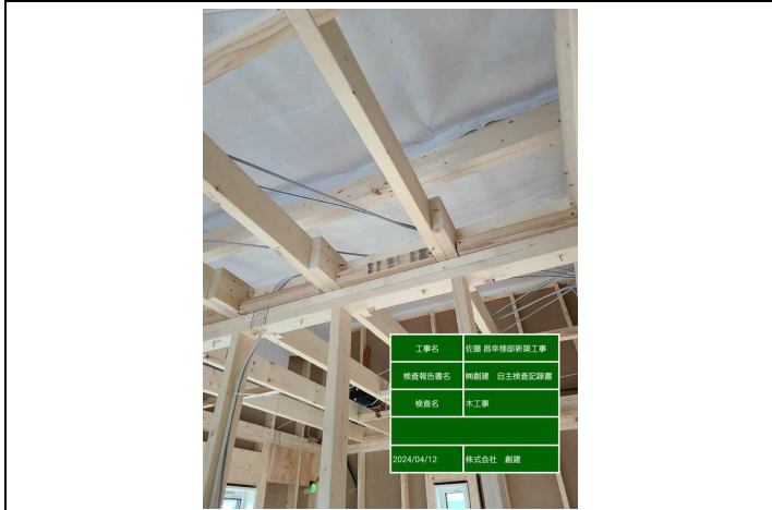
【造作】小屋裏遮熱材の施工
