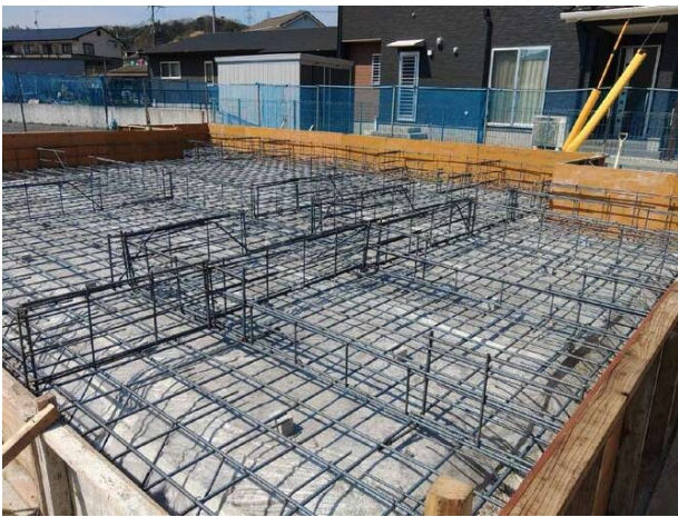
【配筋】配筋全景確認
