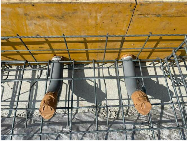
【屋外】給排水管の基礎貫通部 仕舞いは良いか？
