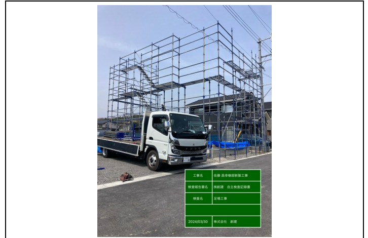
☑組立完成② (全体)
