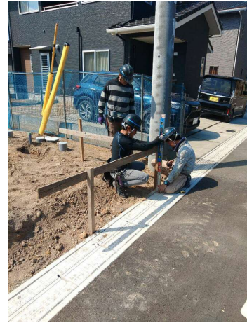
【遣方】遣方天端の確認（BM+□mm=設計GL）
