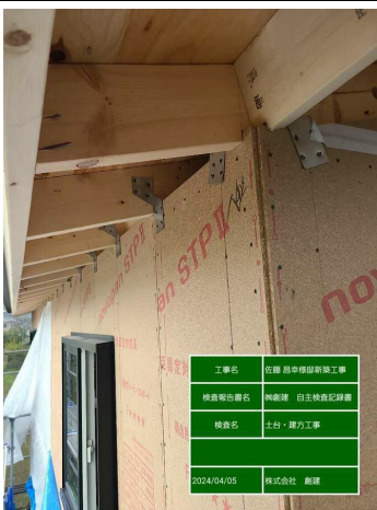
【建方】あおり金物・帯金物・ホールダウンは伏図通りか？
