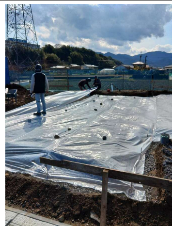
【防湿フィルム】 防湿フィルムが施工されている（重ね巾150mm以上）
