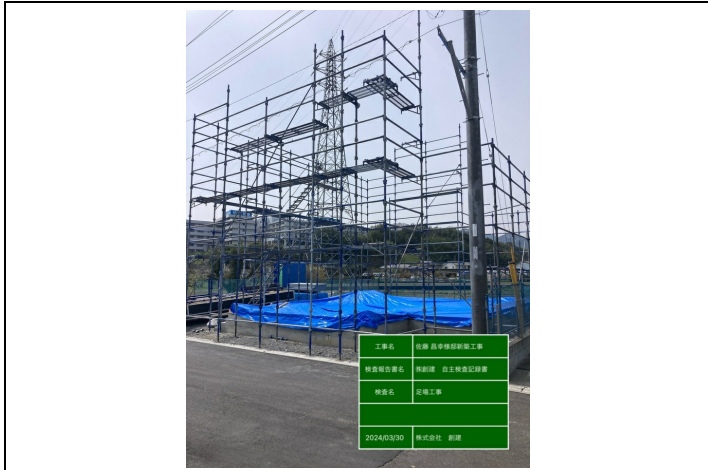
☑組立完成① (全体)
