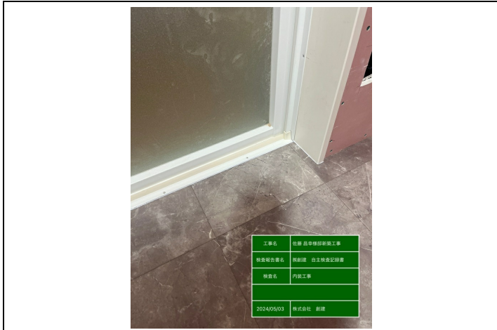
【クッションフロア】浴室入口取合コーキング打ちの確認
